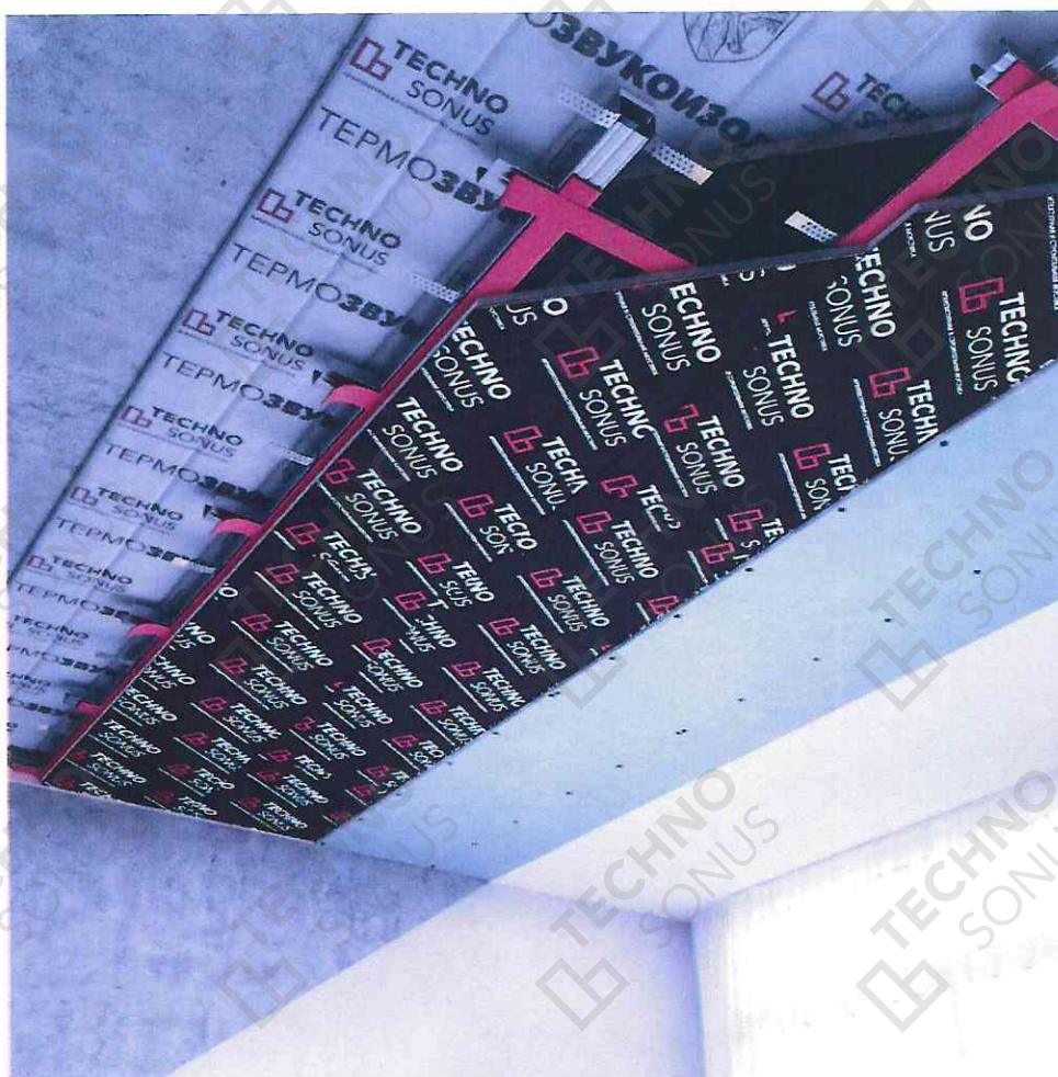
Рисунок 1 - Визуализация системы звукоизоляции «Стандарт М1»
