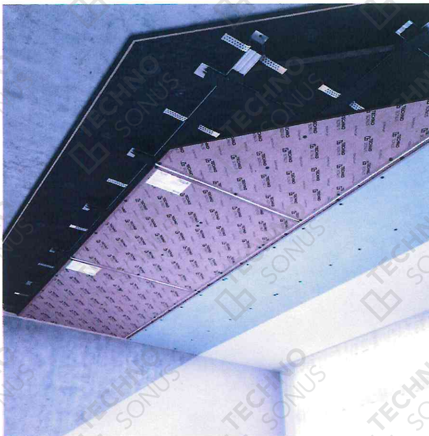
Рисунок 1 - Визуализация системы звукоизоляции «Премиум П»
